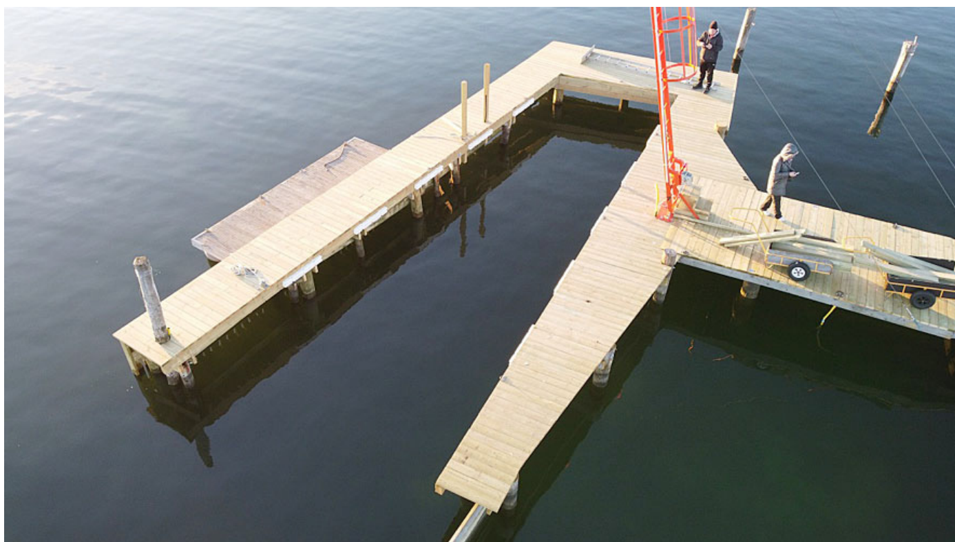
Renoverad mastkran och ny brygga
